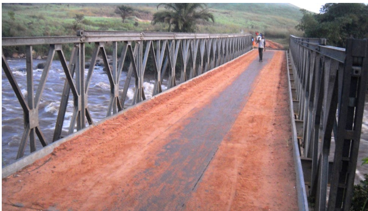
Le pont sur la Lubi, à l'entrée-sortie de Kabeya-Kamuanga. (Photo équipe locale, 2010.)
