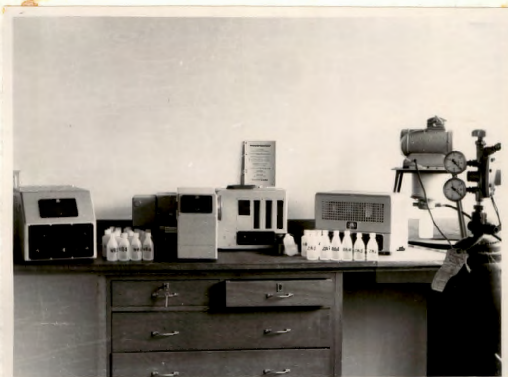
Zeiss-Spektrofotometer (PMQII), toegerus met vlameenheid (FA2) vir emissie- en atoomabsorpsiebepalings.
