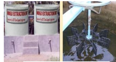
Δεξαμενή και αναμικτήρας
