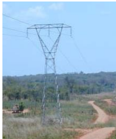
Figura 3. Configuração recomendada para a LT aérea de 110 kV proposta
