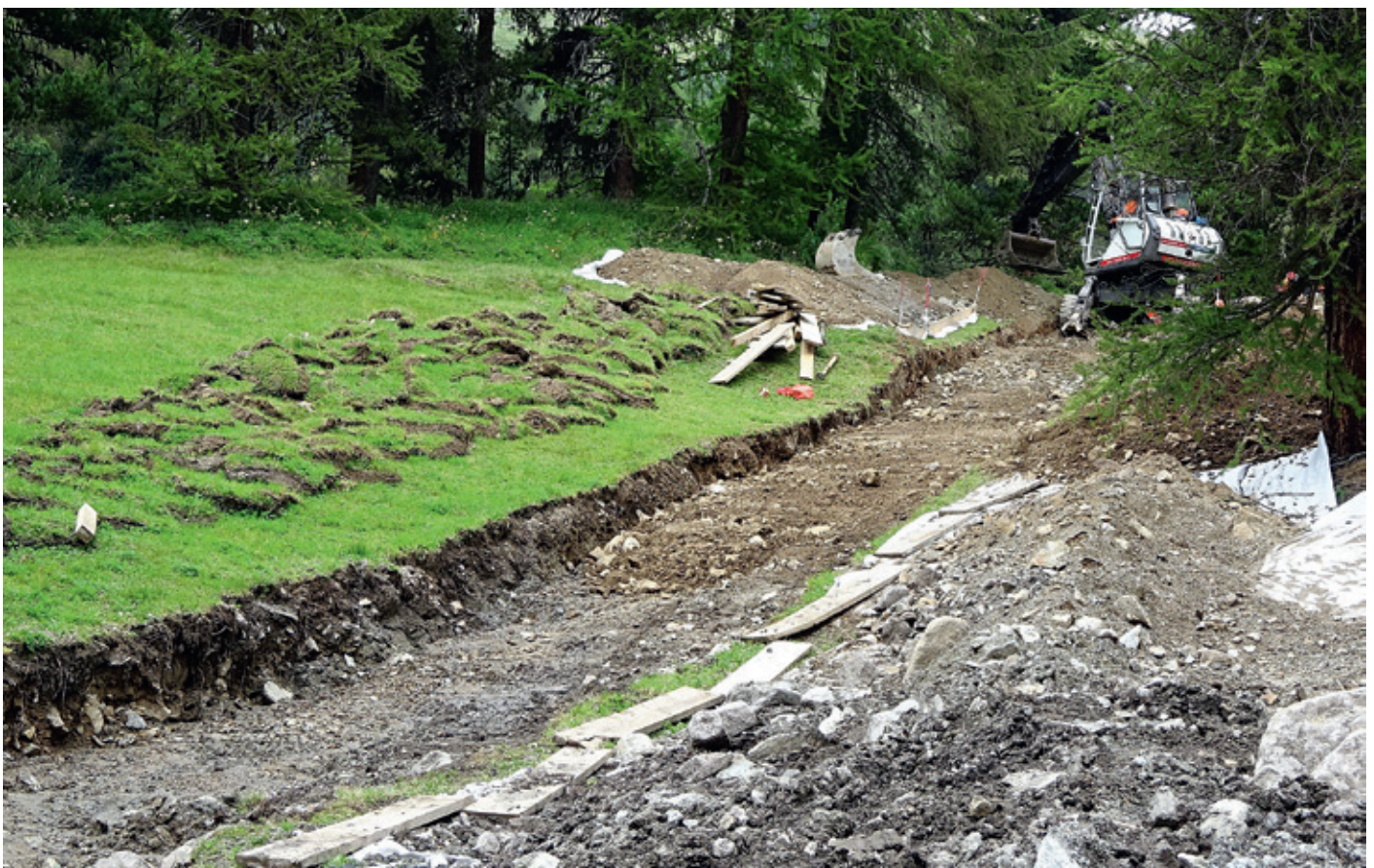
Kurzfristige Lagerung von Soden direkt auf der bestehenden Vegetation. Die Bodendepots werden auf Vlies geschüttet. / Stockage à court terme des plaques de gazon directement sur la végétation existante. Les mottes de terre sont déposées sur un revêtement de séparation. (Photo: Kirsten Edelkraut)
