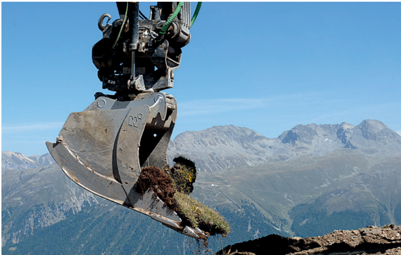
Die abgeschälten Soden werden umgehend wieder am Zielort eingesetzt. / Les mottes dégagées sont réimplantées sans attendre sur le site de destination. (Photo: Tobias Schmid)
