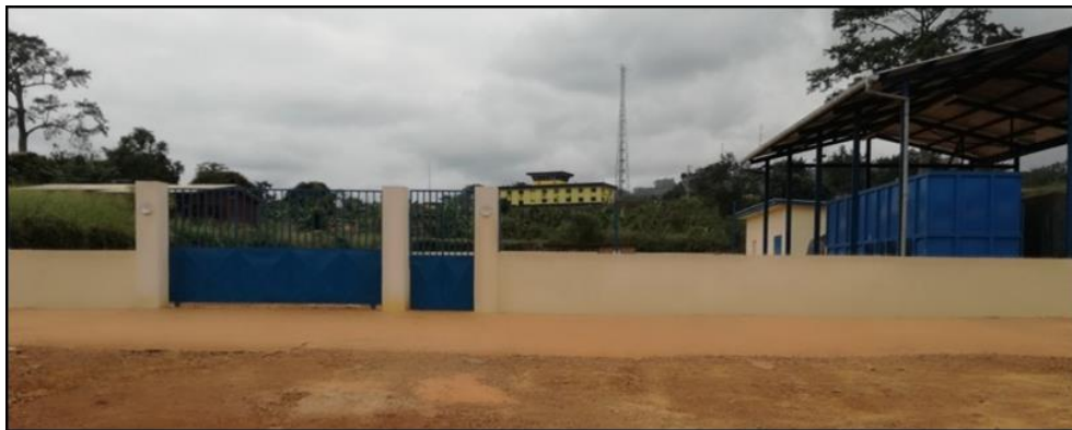
Photo 62 : Station de traitement des eaux de la SEEG (carrefour nouveau pont)
