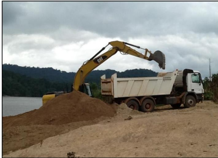
Photo 2 : chargement du sable dans les camions à l'aide d'une pelle excavatrice
