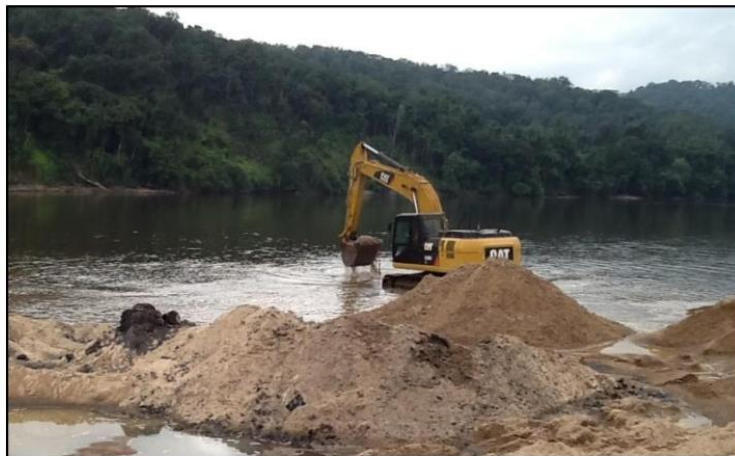
Photo 1 : une vue de l'extraction par pelle excavatrice au large du fleuve
