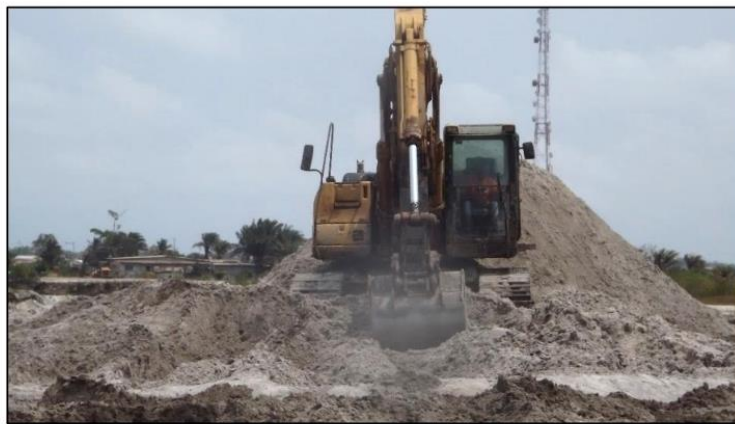
Photo 7 : exemple de pelle pour chargement de sable stocké
