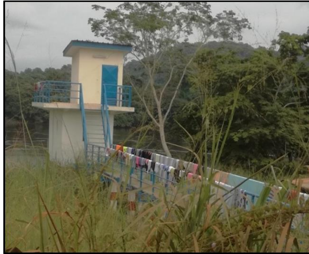
Photo 61 : Nouvelle station de pompage d'eau de la SEEG
