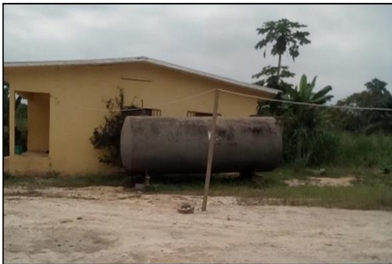
Photo 65 : Maison en dur finie avec commodités intérieures et fourniture normale d'électricité (Tsombial)
