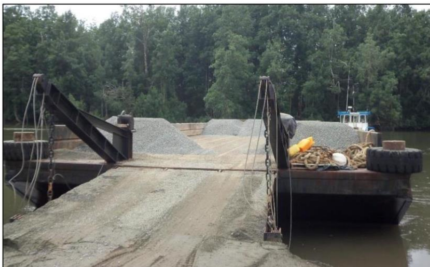
Photo 10 : plateforme chargée du matériau sur la REMBOUE
