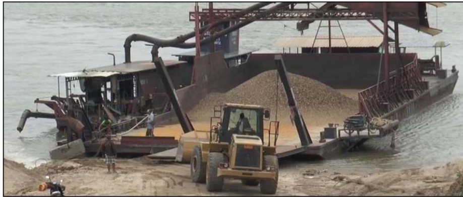
Photo 11 : déchargement de matériaux sur une plateforme à l'aide d'une chargeuse sur pneus
