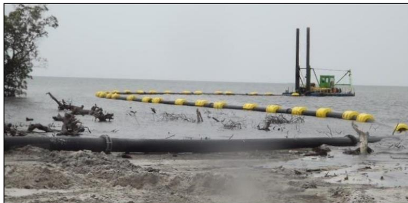
Photo 5 : exemple d'une barge équipée d'une pompe suceuse et d'un tuyau de refoulement
